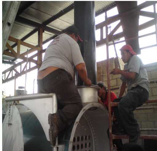
Figura 38. Acoplamiento de chimenea a caldera
