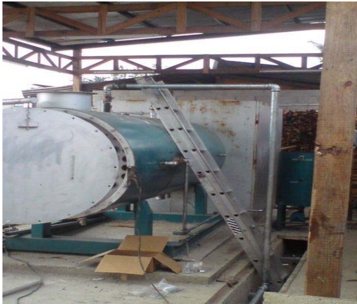
Figura 32. Conexión de tubería de vapor
