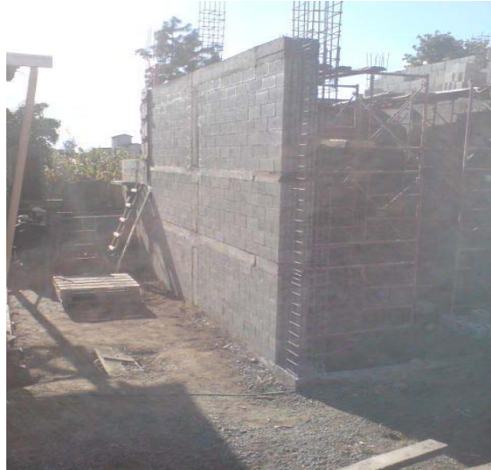
Figura 8. Levantado de muro de block
