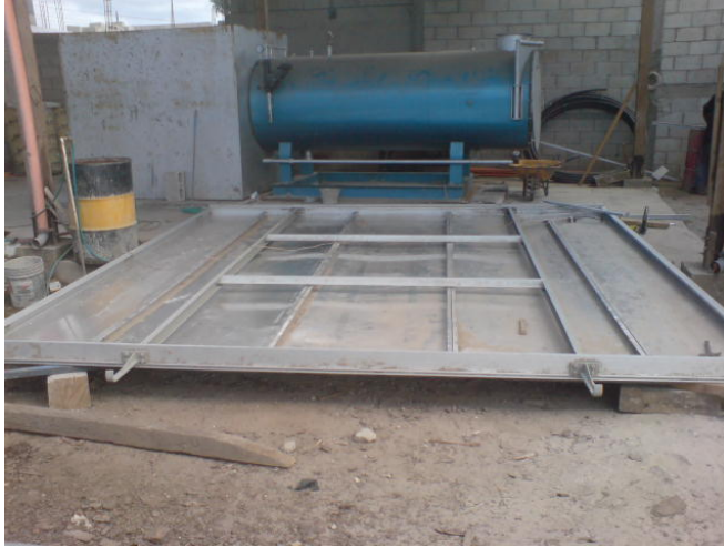
Figura 16. Colocación de tensores internos de compuerta
