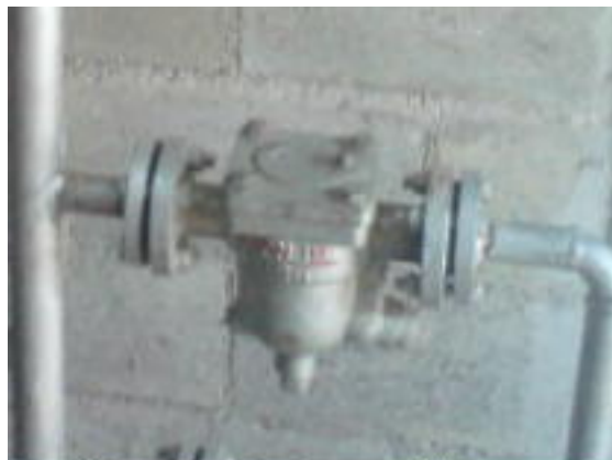
Figura 29. Trampa de vapor
