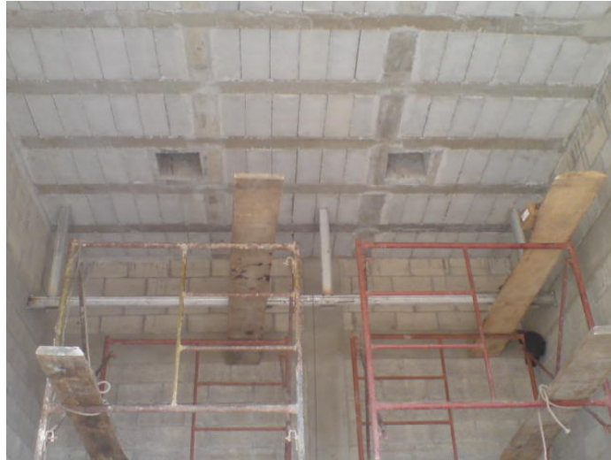
Figura 19. Ensamblaje de estructura de soporte de intercambiadores de calor
