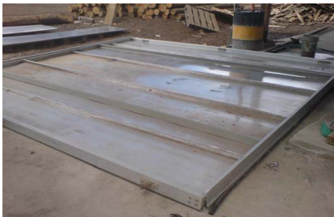
Figura 15. Instalación de lámina a cara interna de compuerta
