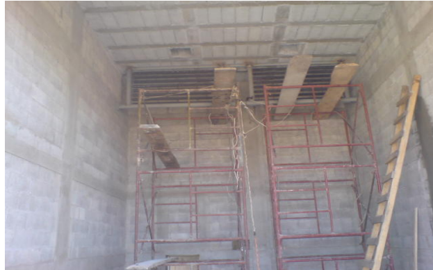
Figura 21. Intercambiadores de calor instalados
