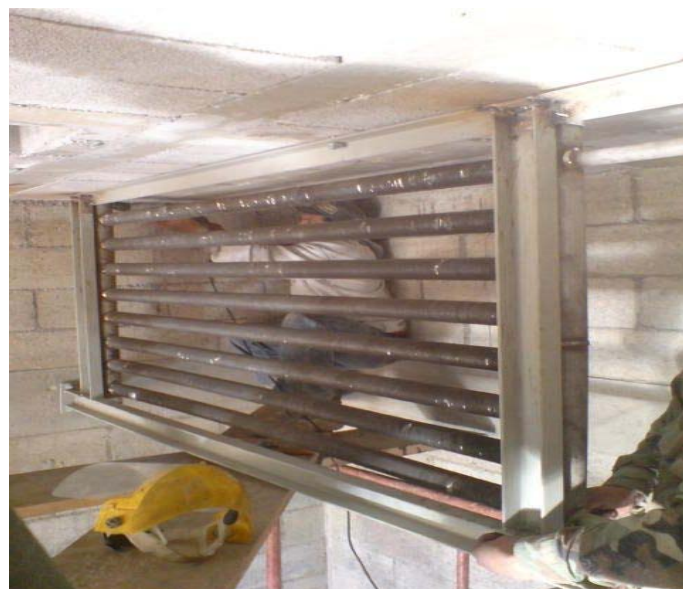
Figura 20. Instalación de intercambiadores de calor
