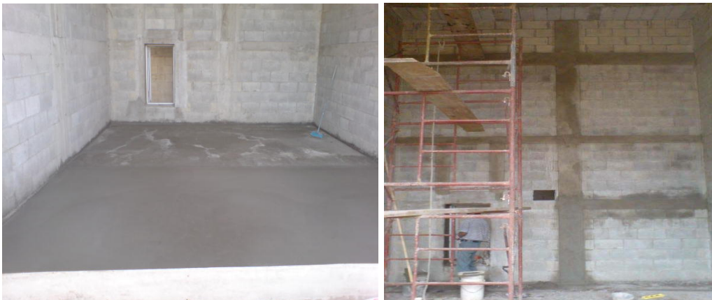
Figura 10. Fundición de losa de piso y acabados finales
