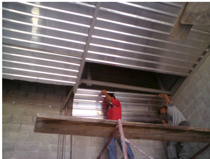
Figura 23. Colocación de lámina de cortina
