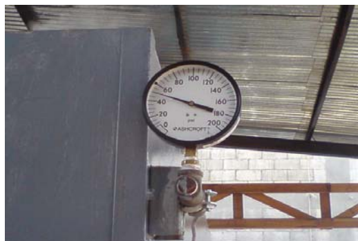
Figura 35. Manómetro de presión de vapor
