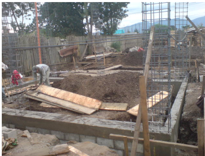
Figura 7. Fundición de cimentación
