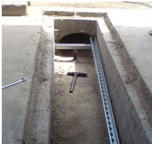
Figura 30. Instalación de soportes de tubería de vapor
