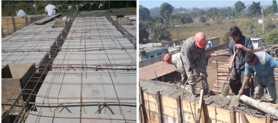
Figura 9. Supervisión de armado y fundición de losa de techo
