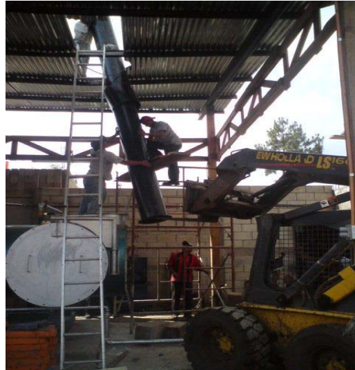
Figura 37. Instalación de chimenea
