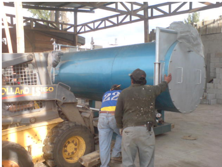
Figura 28. Montaje de caldera
