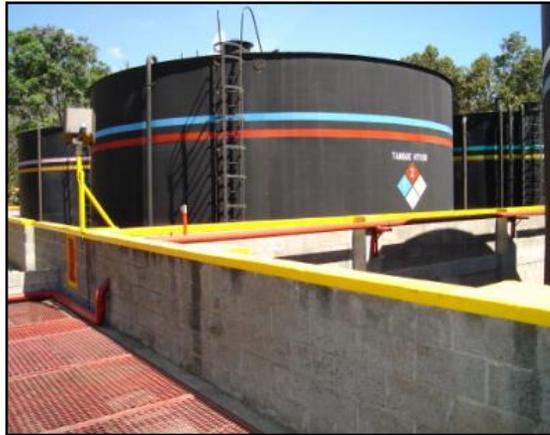
**Figura 2. Tanque de almacén de combustible diesel**
