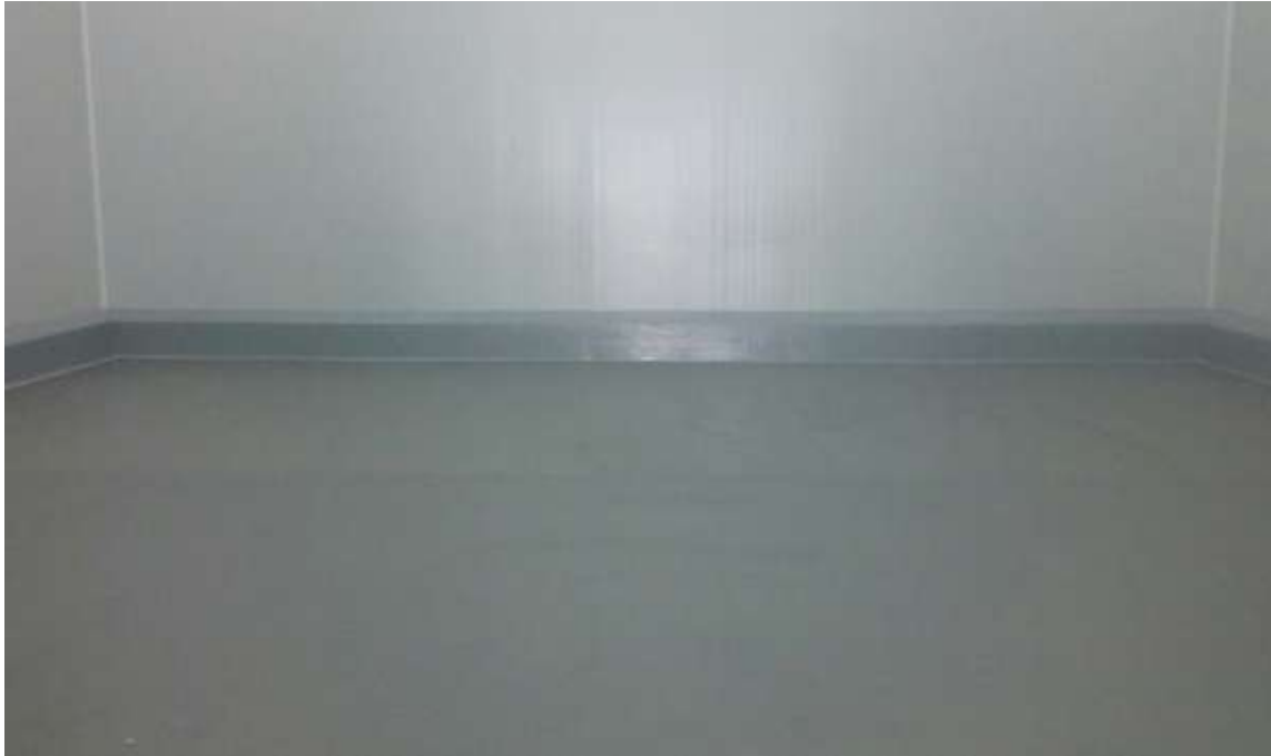
Figura 15. Piso de concreto
