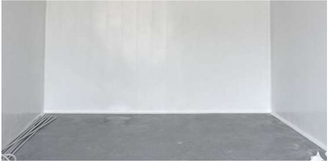
Figura 16. Pared de concreto con recubrimiento sanitario
