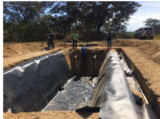
Instalación de geomembrana
