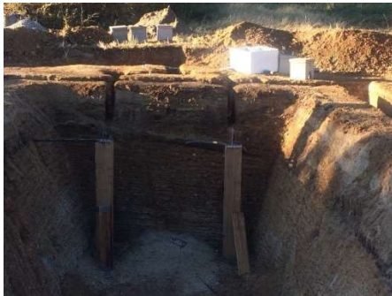
Columnas de soporte
