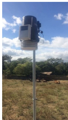
Estación automática instalada
