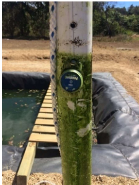
Sensor de temperatura en funcionamiento
