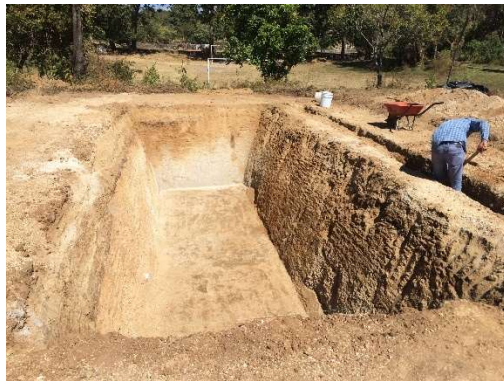
Construcción de zanja perimetral
