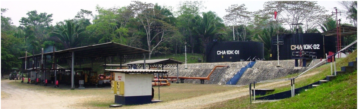
Figura 2. Estación de bombeo.
