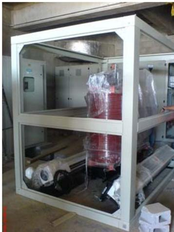
En las fotografías anteriores se puede observar el montaje mecánico de las celdas de media y baja tensión, así como el montaje de un transformador seco de Geafol de 1500 KVA con su cubierta protectora.
