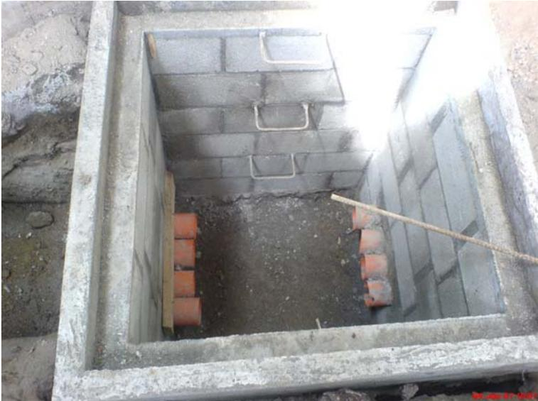
**Figura 24. Proceso de introducción de tuberías para anillo de media tensión Finger Norte.**
