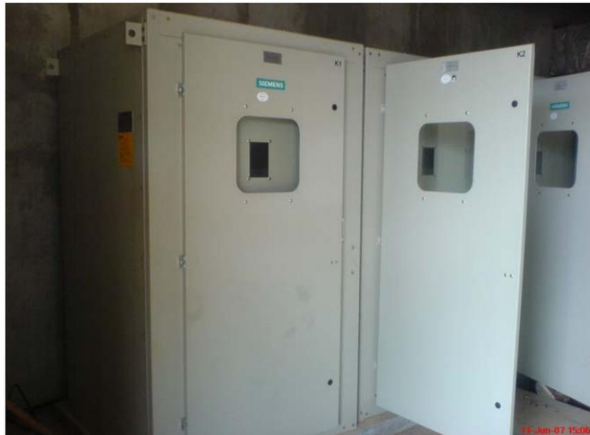
**Figura 31. Celdas media tensión en subestación 3 Finger Norte**
