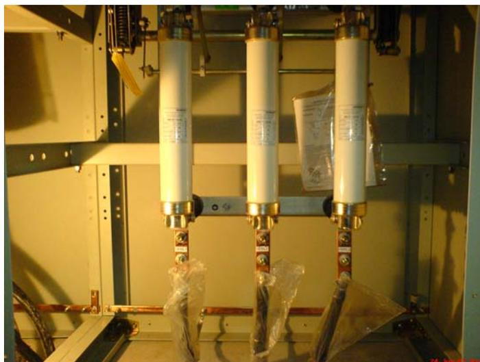
En la figura anterior se pueden observar los fusibles y la conexión de mufas de la celda de salida hacia el transformador en la subestación 3 del Finger Norte, estos fusibles fueron calculados según capacidad de la subestación tomando en consideración la tabla de selección de fusibles antes mostrada.
