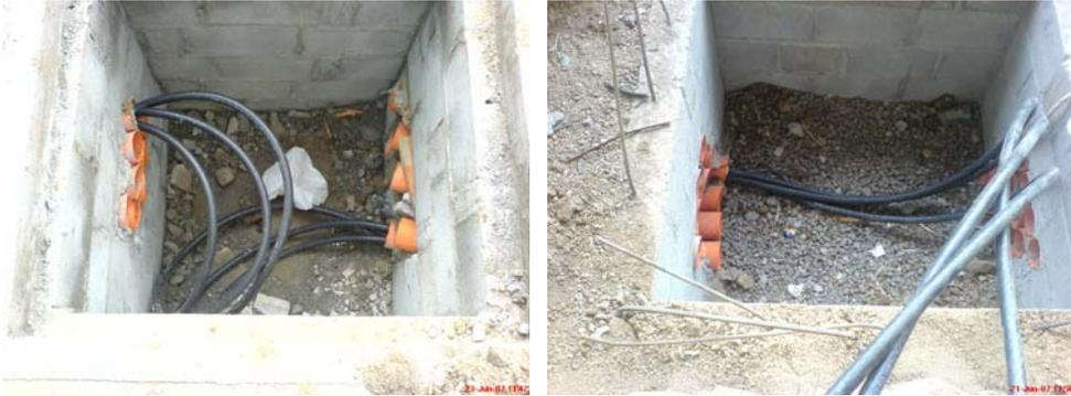
**Figura 37. Proceso de alambrado de media y baja tensión de transformadores.**
