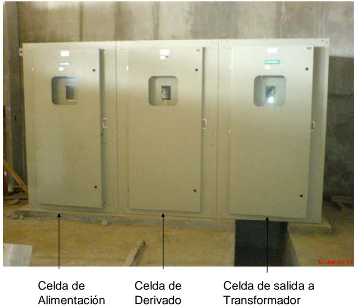
Para una mejor comprensión de la conexión de las celdas en cada subestación ver plano 10.6.
