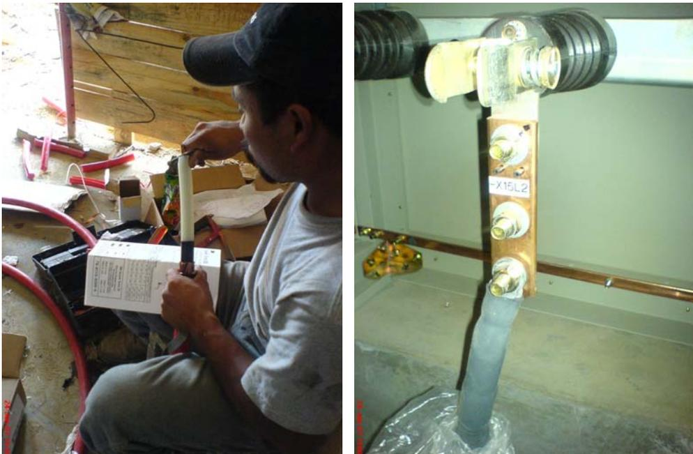
En las fotografías anteriores se puede observar el alambrado de media y baja tensión de un transformador de 1500 KVA 13.2/7.6KV – 480/277V, así como la preparación de las terminaciones (mufas) de interior para las celdas de media tensión.
