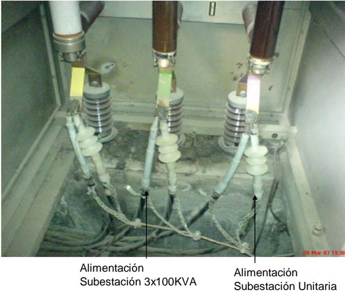
**Figura 16. Subestación tipo bóveda de 3X100KVA**
