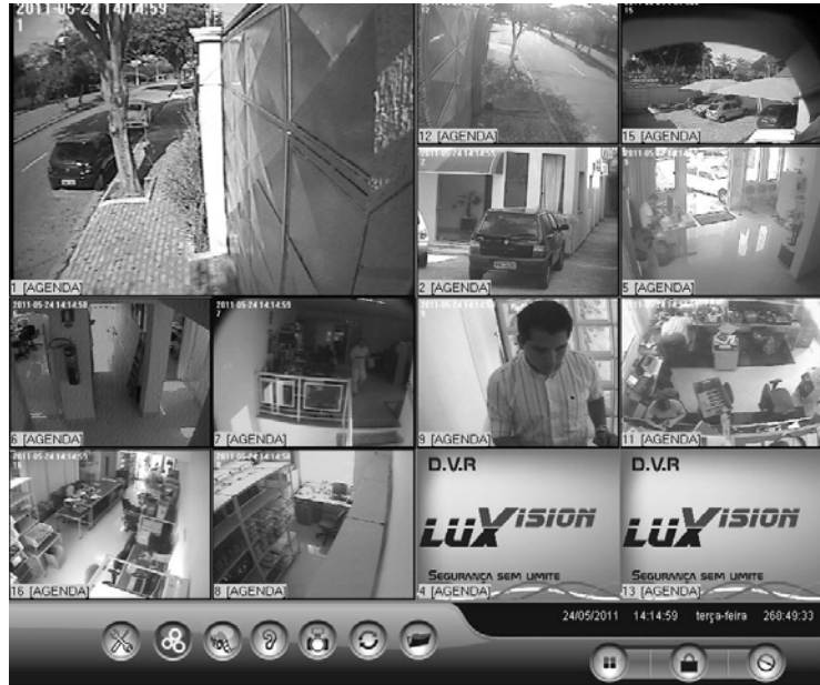
Figura 8. Circuito de cámaras de seguridad instalado
