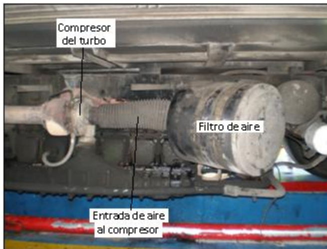
Figura 20. Filtro de aire
