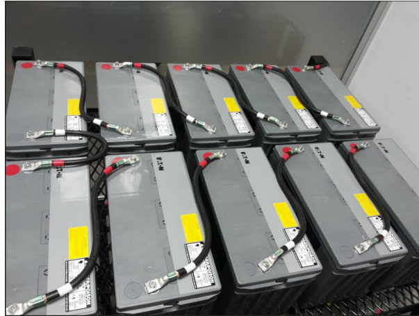
Figura 16. Batería de UPS
