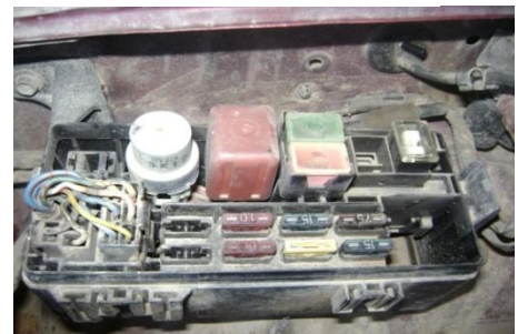
Figura 48 Caja de Fusibles
