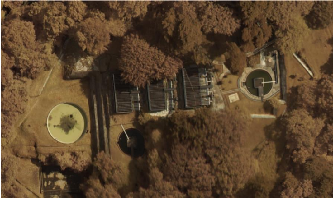
Figura 7. Vista aérea PTAR USAC
