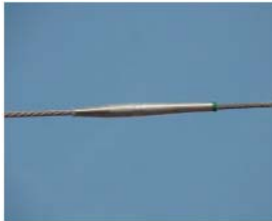
Figura 23. Empalme a plena tracción
