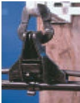
Figura 31. Grapa de suspensión para B.T.
