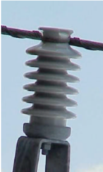
Figura 2. Características de los aislador tipo poste de porcelana
