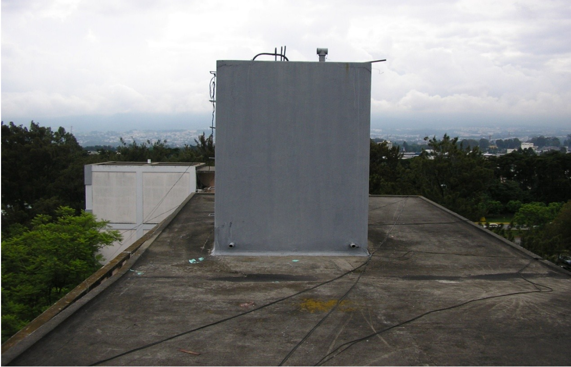
Figura 6. Tanque de captación de agua edificio T3
