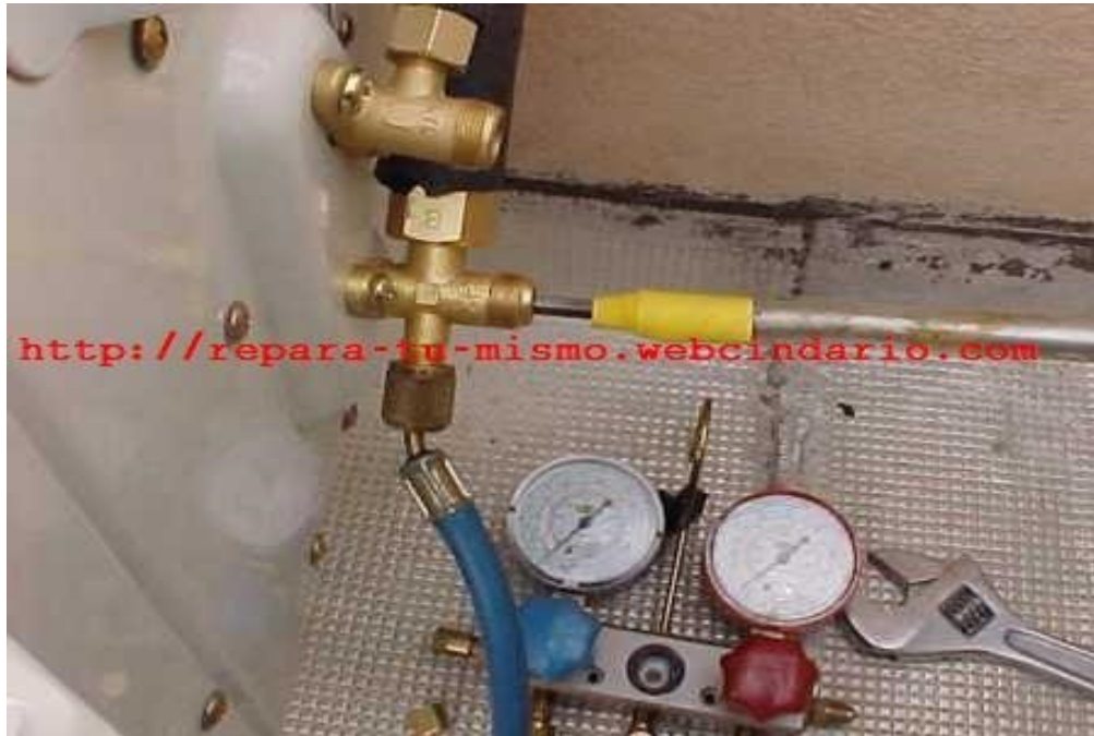
Figura 17. Conexión al sistema de acondicionamiento de aire
