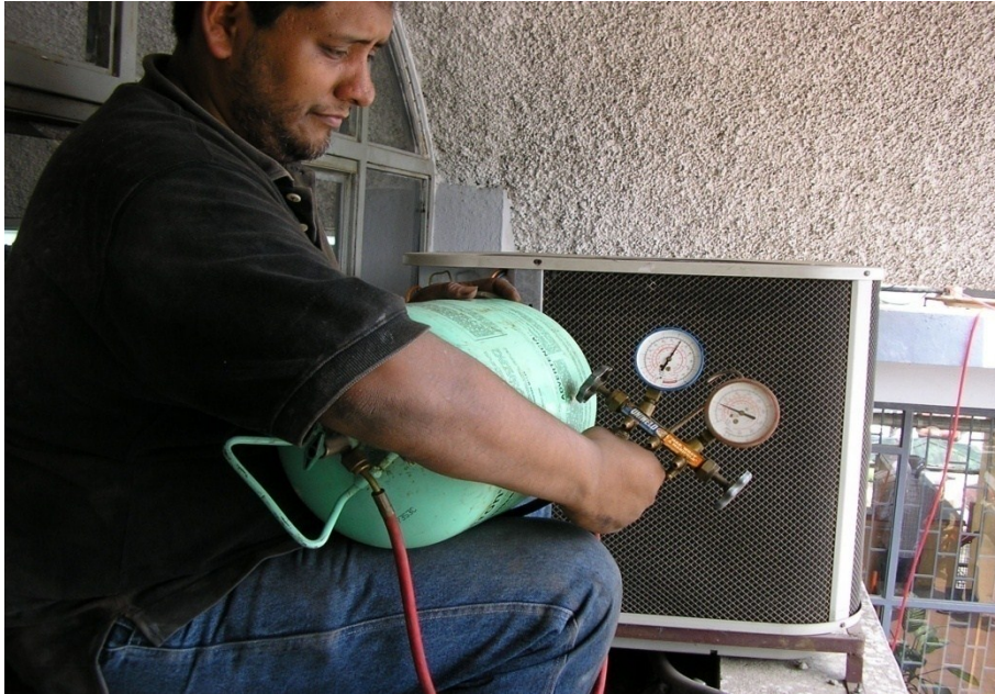
Figura 18. Conexión al sistema de acondicionamiento de aire
