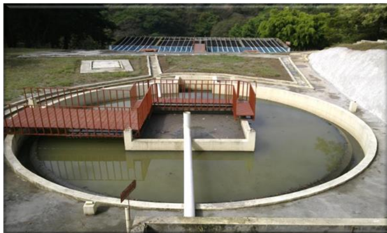
Figura 16. Sedimentador primario
