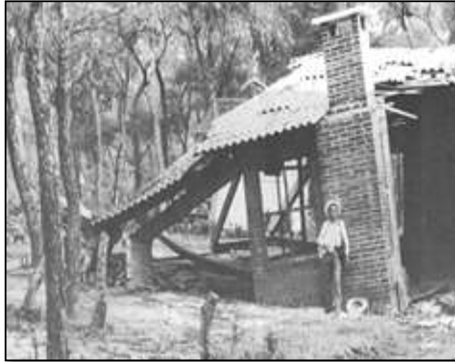
Figura 8. Colapso de vivienda, propagación lateral por diferencial vertical causado por la licuación del suelo
