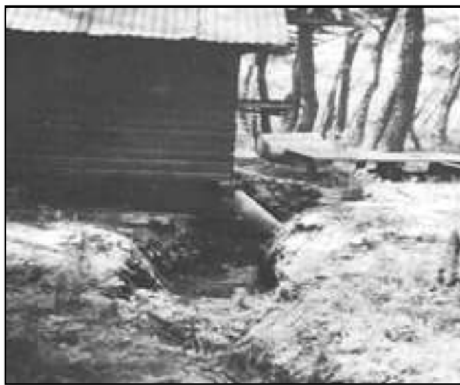
Figura 10. Desplazamiento lateral de suelo en vivienda apoyada por pilotes de madera, al noreste del delta del río Villalobos
