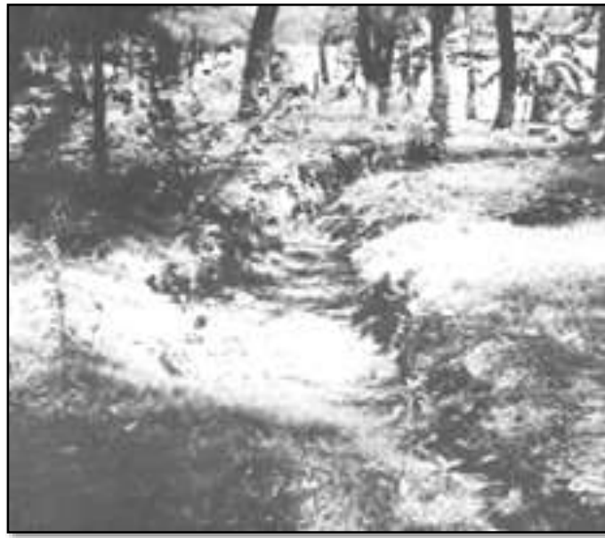
Figura 11. Grieta por propagación lateral de esfuerzos inducidos por sismos, desplazamientos diferenciales verticales, en comunidad La Playa, después del terremoto del año 1976, abril 1976
