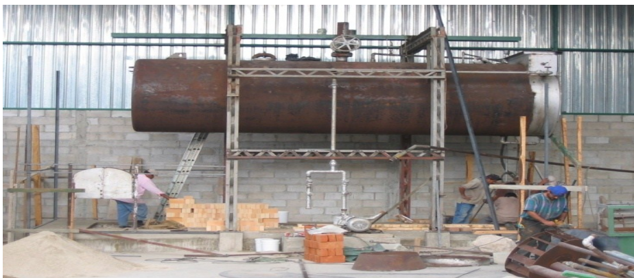
Figura 14. Fabricación de soportes tipo H para elevación de caldera
