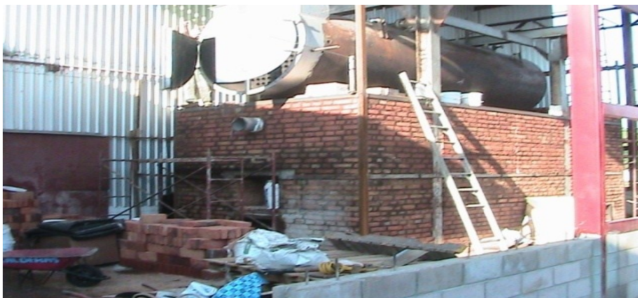
Figura 15. Construcción de horno inferior o tipo túnel
