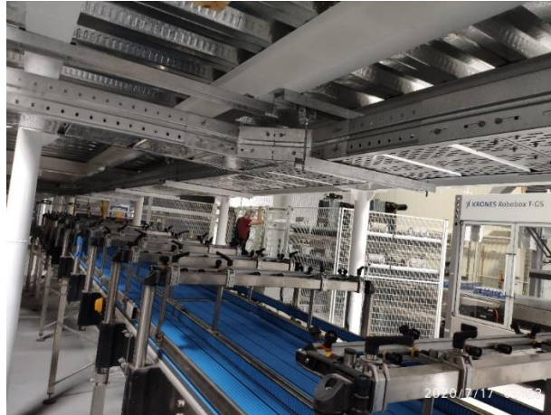
Figura 6. Fotografías en implementación de la línea de llenado y pruebas a cableados, 3
