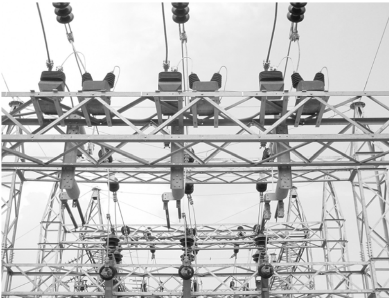
Figura 1. Medición trifásica archivo de Servicios Técnicos Especializados EGEE.
