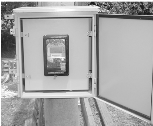
Figura 5. Medidor ABB ION 8400 foto de trabajo de campo.
