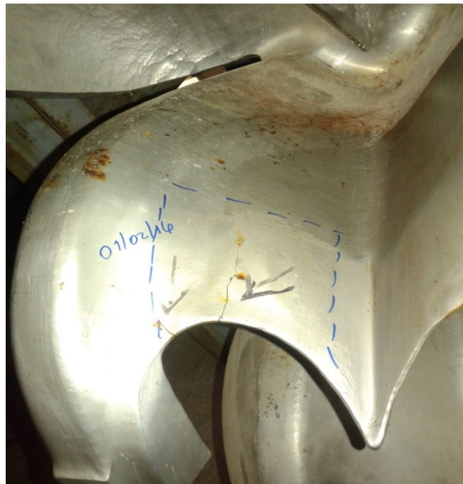
Figura 57. Daños por operación de rodetes
