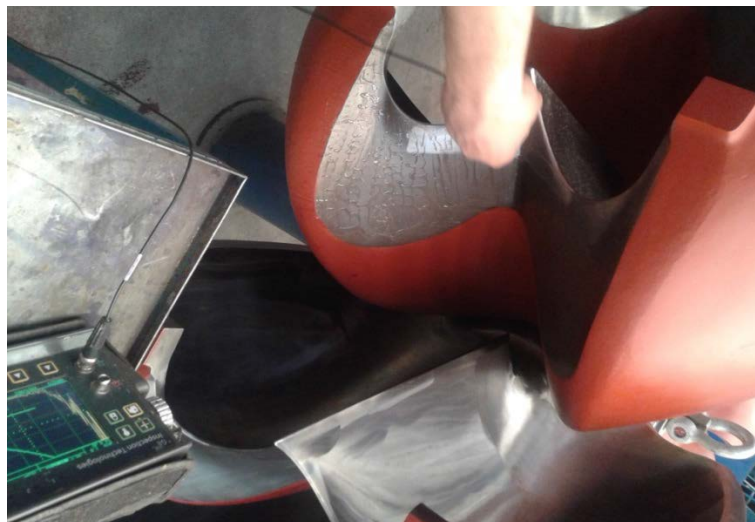
Figura 81. Ensayo no destructivo por ultrasonido a soldadura
