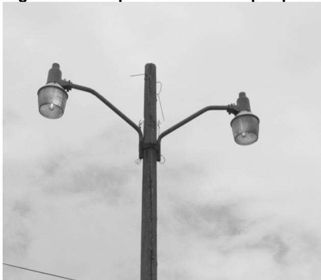
**Lámparas de vapor de mercurio a alta presión.** A medida que aumentamos la presión del vapor de mercurio en el interior del tubo de descarga, la radiación ultravioleta característica de la lámpara a baja presión pierde importancia
