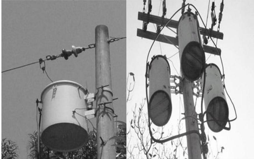
La capacidad del banco de transformación, en un sistema monofásico es el valor de potencia indicado en el transformador en KVA, mientras que un sistema trifásico es la suma de la potencia individual de cada transformador en KVA. La capacidad de los bancos en cuestión es:
