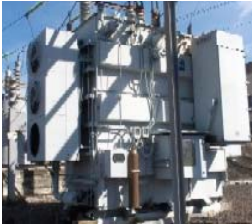
Figura 6. Transformador de Potencia, utilizado en Subestaciones eléctricas.
