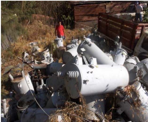
Figura 19. Cementerio de Transformadores.
