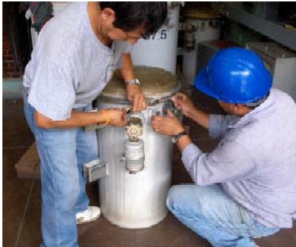
Figura 22. Trabajadores destapando un transformador de distribución.
