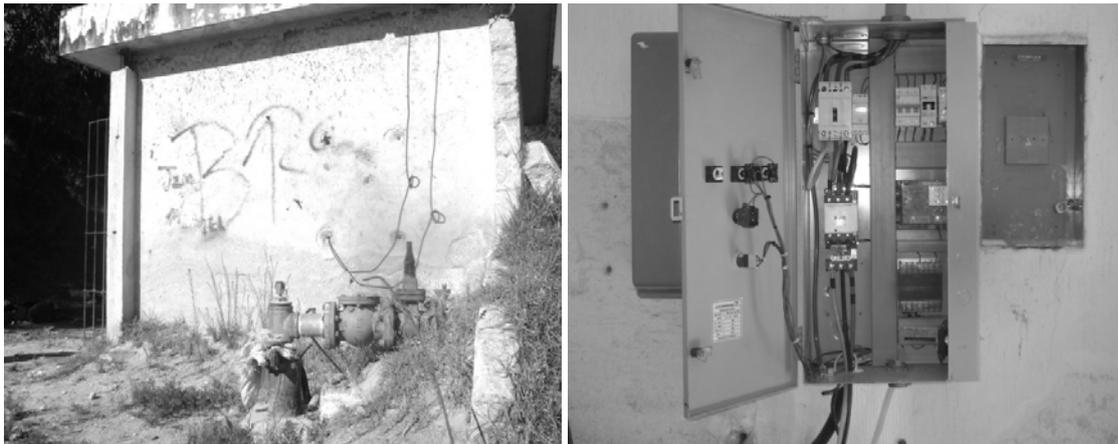
Figura 31. **Pozo Marroquín. Bomba de turbina sumergible, lubricada con agua, con potencia de 40 hp. Con panel de control y banco de transformadores para 240 a 480 Watts**
