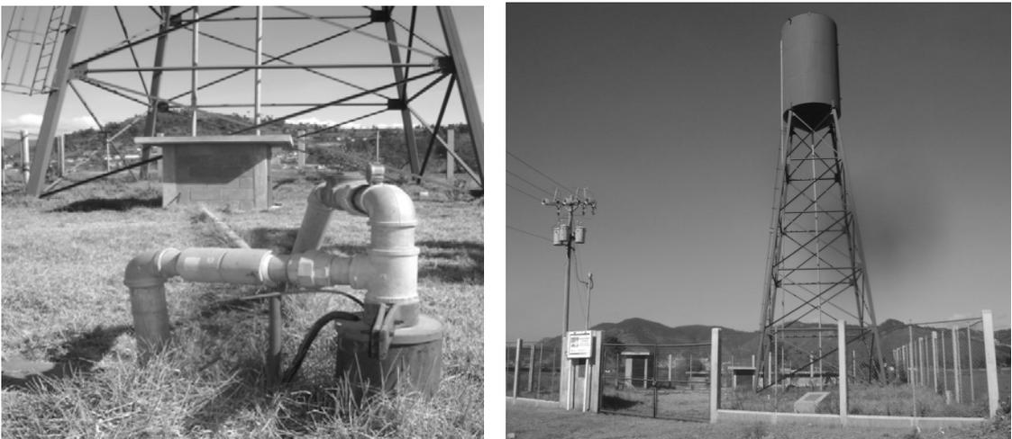
Figura 34. **Pozo Santa Rita. Bomba de turbina sumergible, lubricada con agua, con potencia de 40 hp. Con panel de control y banco de transformadores para 240 a 480 Watts**
