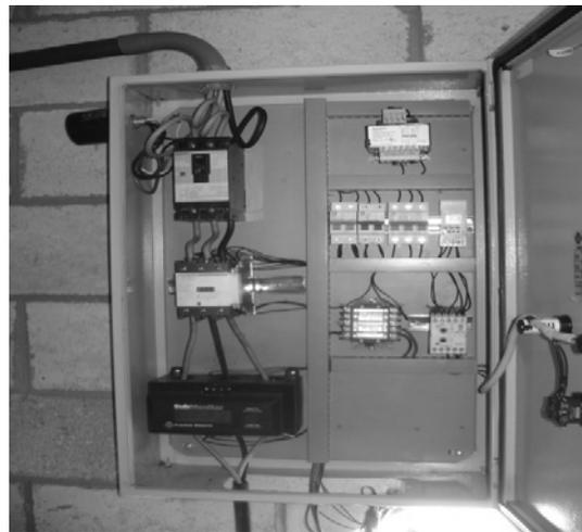
Figura 30. **Pozo El Zanjón. Bomba de turbina sumergible, lubricada con agua, con potencia de 40 hp. Con panel de control y banco de transformadores para 240 a 480 Watts**
