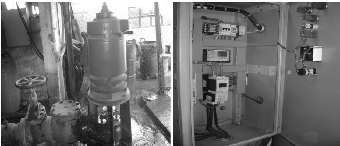
Figura 27. Pozo San Jacinto. Bomba de eje vertical, lubricada con agua, con potencia de 40 hp. Con panel de control y banco de formadores para 240 a 480 Watts
