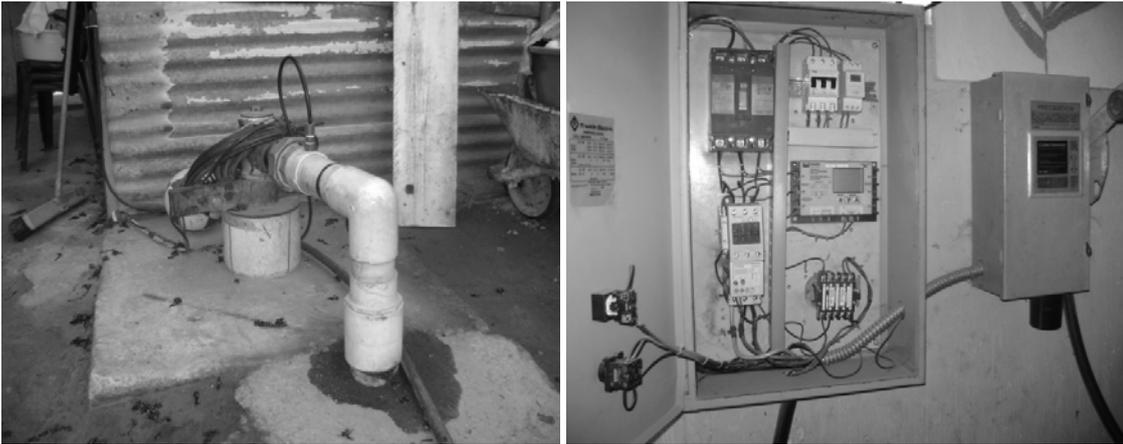
**Figura 33. Pozo Porte Zuelo. Bomba de turbina sumergible, lubricada con agua, con potencia de 40 hp. Con panel de control y banco de transformadores para 240 a 480 Watts**
