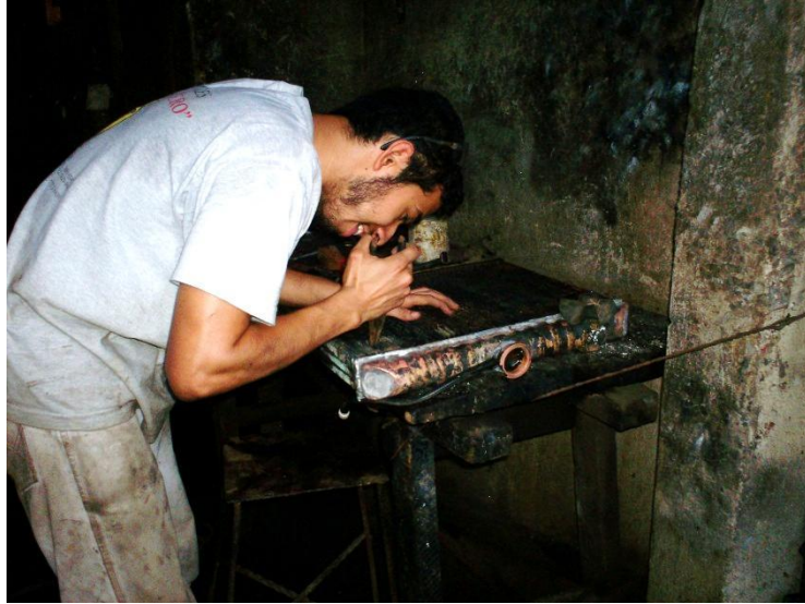
Figura 4. Operario definiendo los puntos donde se necesita soldadura
