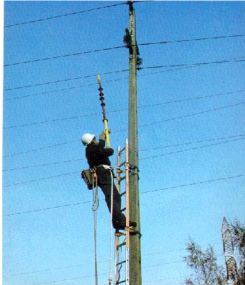
Figura 32: Verificación de ausencia de tensión
