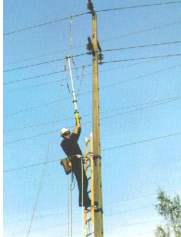
Figura 33: Colocación de tierras temporales
