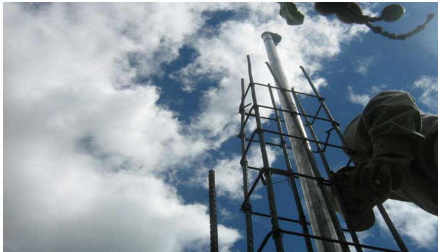
Figura 67. Columna antes de fundir.
