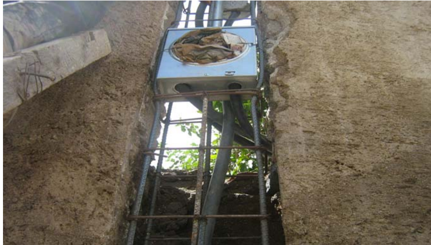
Figura 66. Instalación de tubería de entrada.
