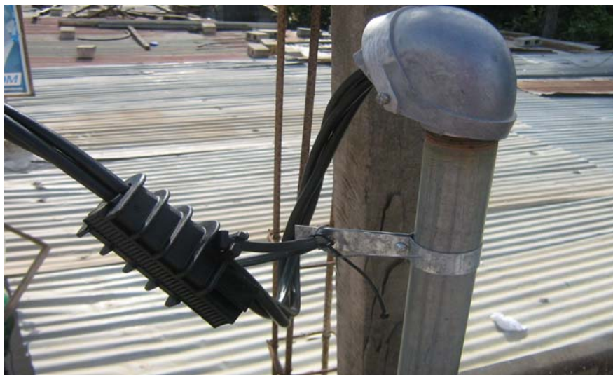
Figura 19. Gancho de sujeción.
