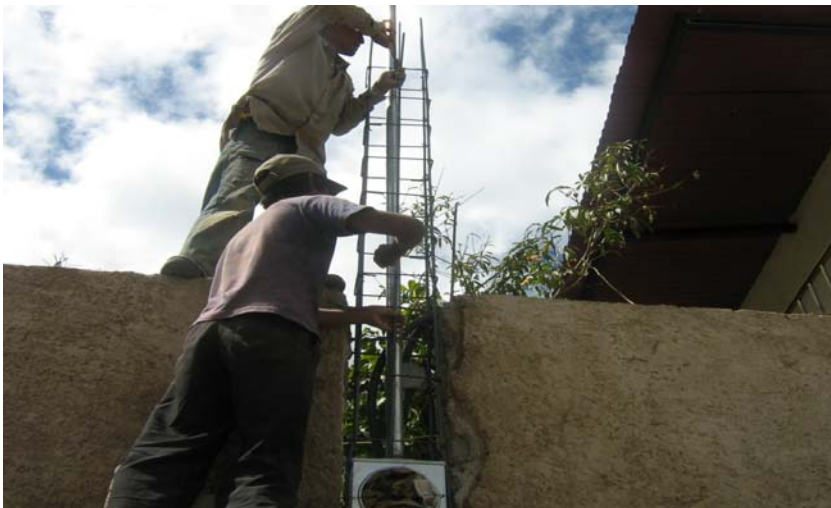
Figura 65. Instalación de tubo conduit.
