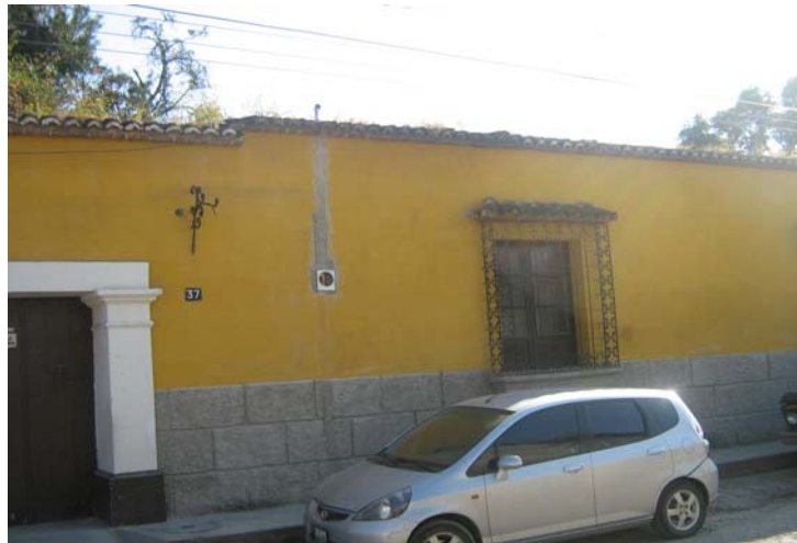
Figura 55. No cruce de calle
