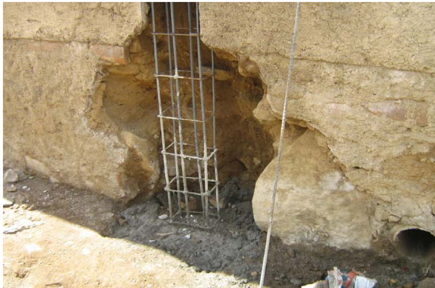
Figura 63. Armado de columna.
