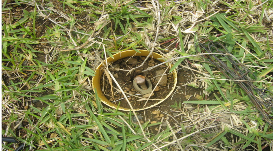
Figura 16. Conector de tierra.
