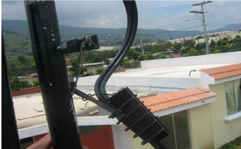
Figura 20. Gancho de sujeción.
