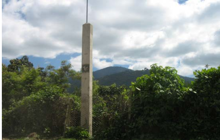
Figura 57. Columna de concreto adecuado.
