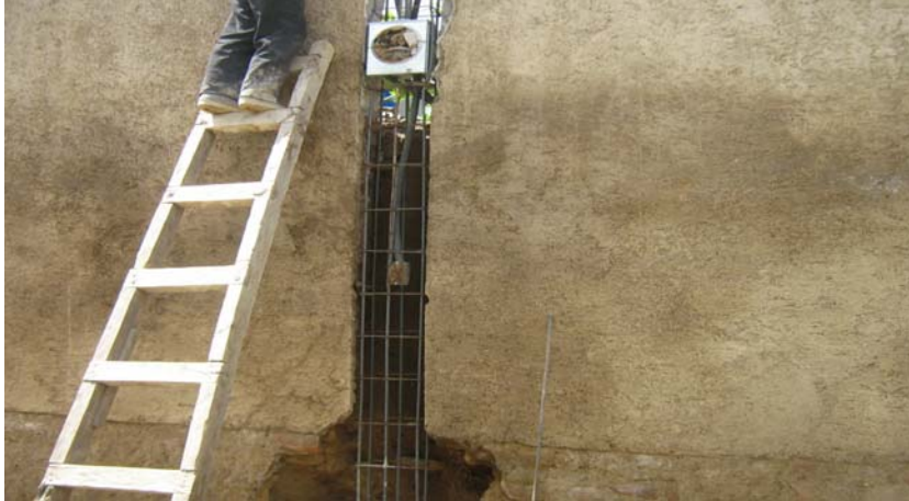
Figura 64. Instalación caja socket.
