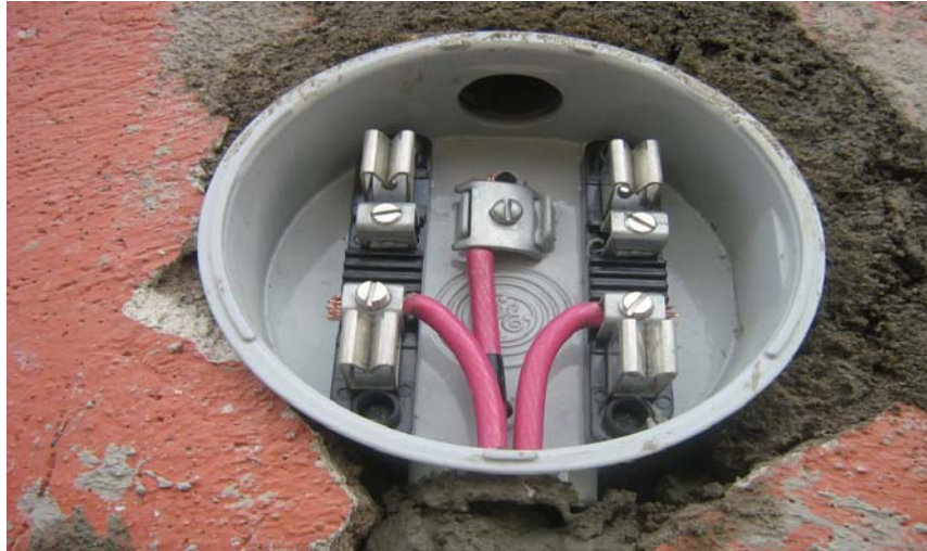
Figura 59. Caja socket redonda
