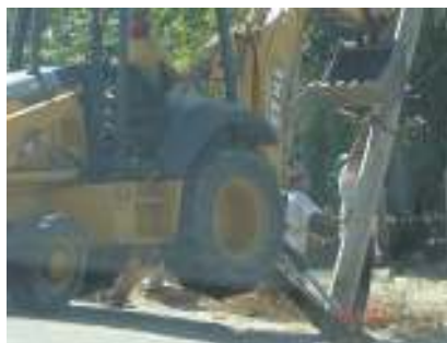
Figura 16. Instalación de poste de concreto
