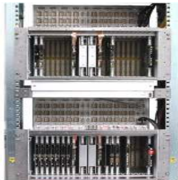
Figura 15. Equipo SDH
