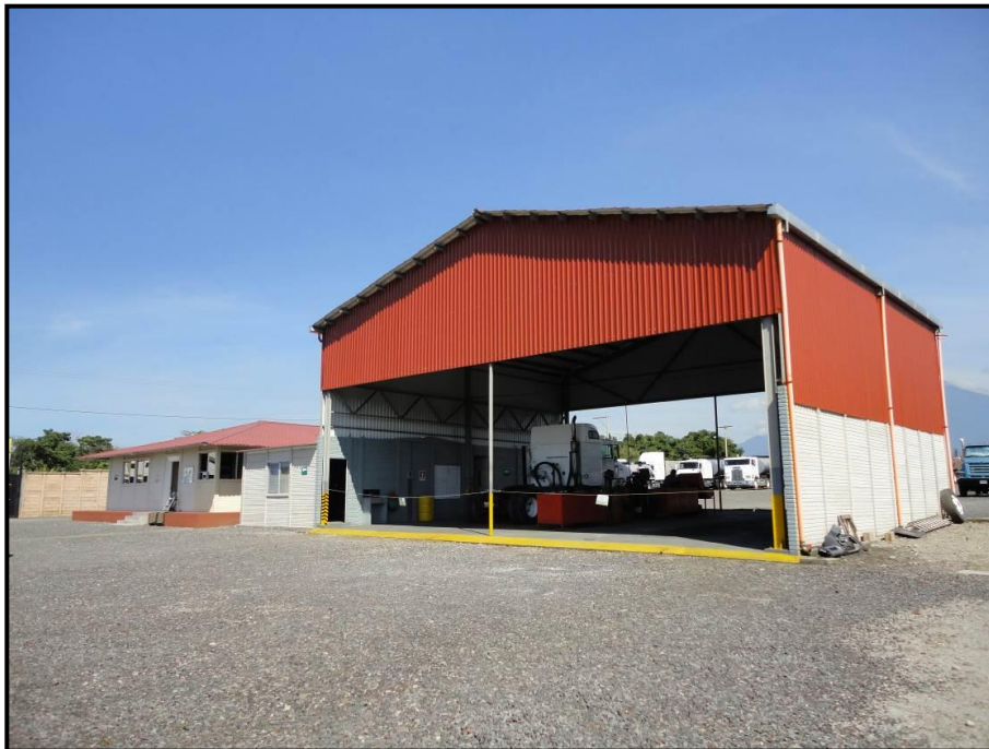
Figura 19. Señalización para las áreas de trabajo
