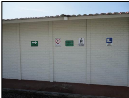
Figura 26. Señalización exterior de las rutas de evacuación
