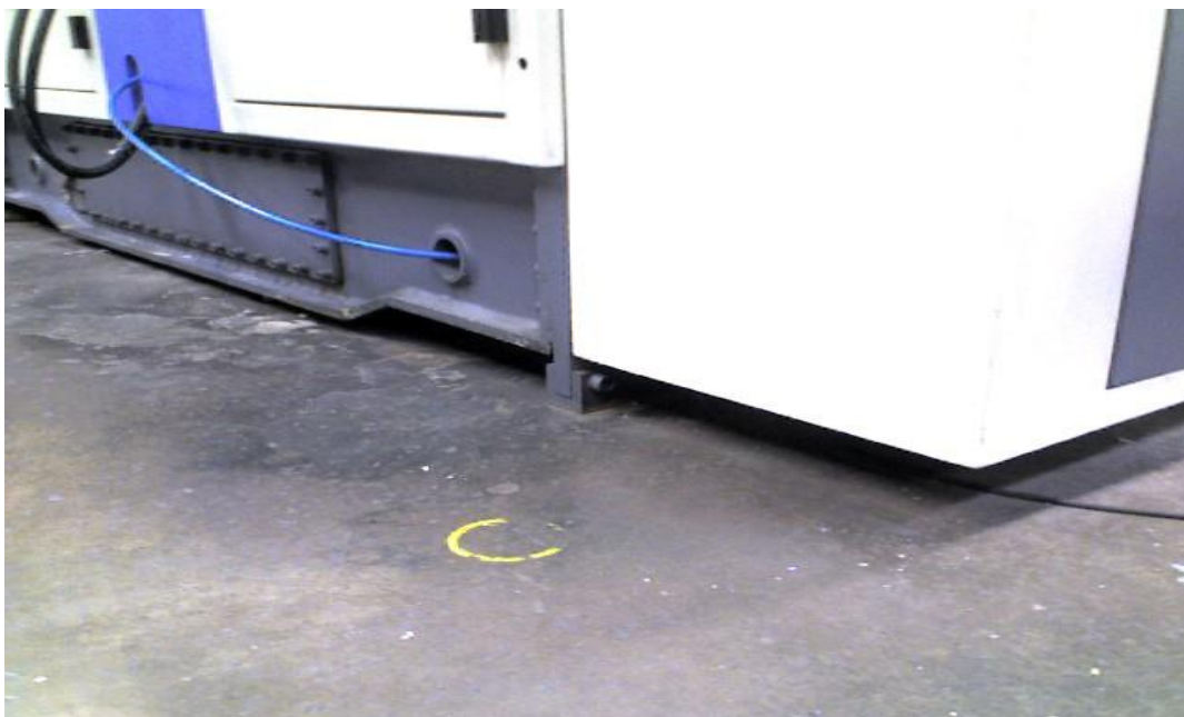
Figura 45. Sopladora sin soportes de amortiguación
