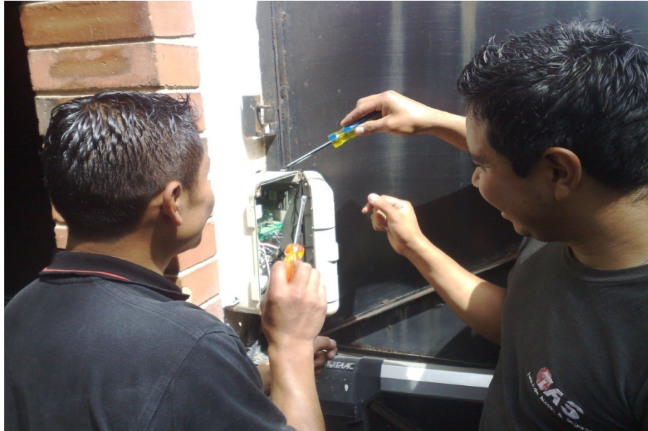
Figura 76. Fotografía practica motor abatible tornillo sin fin
