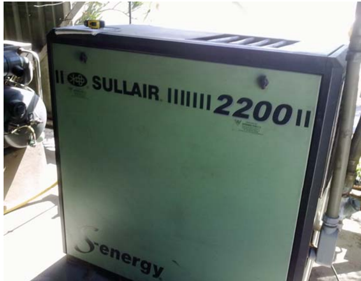
Figura 13. Compresor de tornillo
