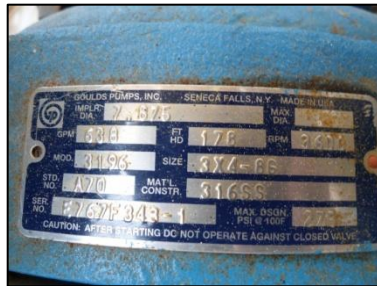
Figura 21. Placa de especificaciones de la bomba I
