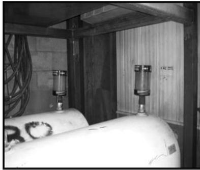
Filtro de respiradero apropiado de 4 micrones con capacidad de remoción de humedad en los tanques de almacenamiento a granel.
