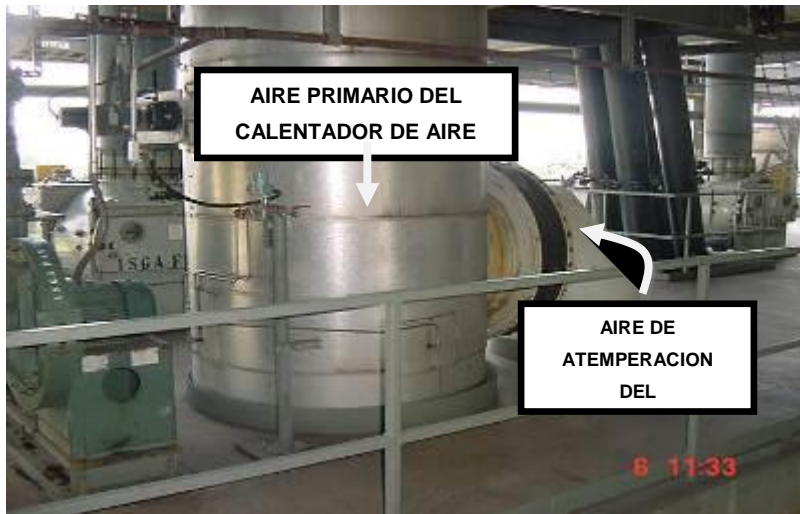
Figura 8. Sistema de aire primario y atemperación
