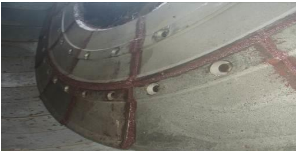
Figura 32. Material cerámico Belzona 1812 aplicado a carcasa inferior
