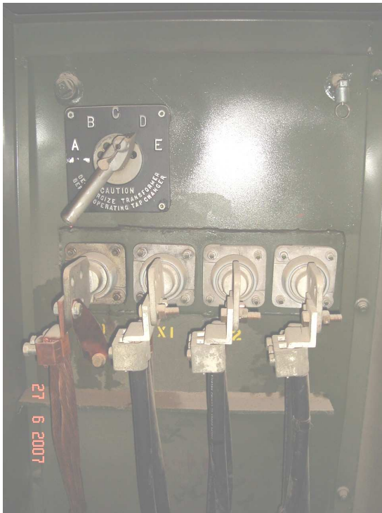
Figura 20. Taps del transformador pad-mounted
