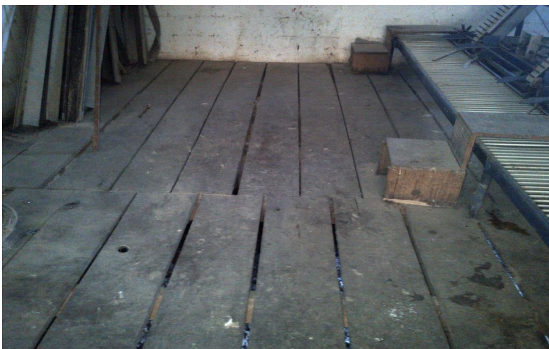
Figura 6. Piso característico galpón automatizado
