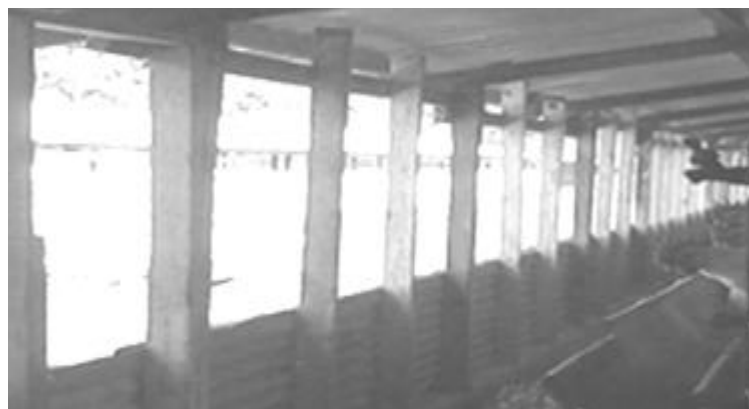
Figura 20. Galpón sin malla de protección contra aves ajenas
