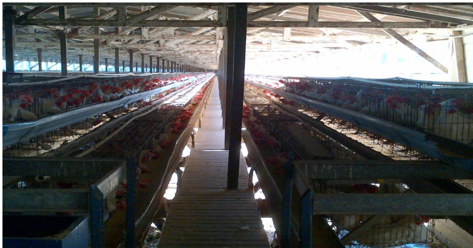
Figura 7. Vista interna galpón automatizado
