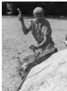
Figura 14. Fracturación de roca con almádana
