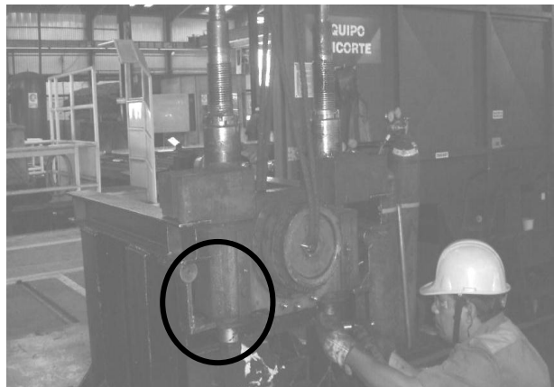
Figura 16. Montaje de chumacera inferior en banco de trabajo
