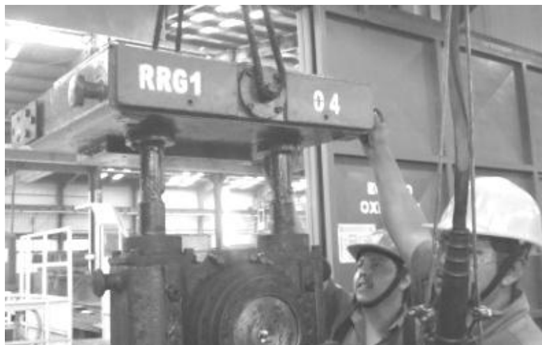
Figura 33. Montaje de gabbia
