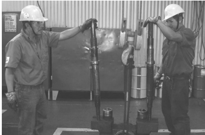
Figura 19. Desmontaje de ejes de regulación vertical
