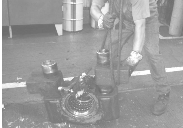
Figura 20. Desmontaje de brazos de carga
