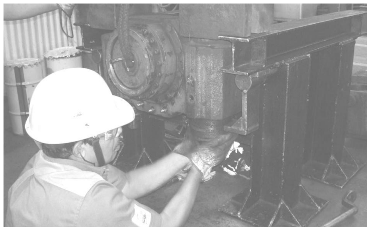
Figura 18. Desmontaje de buje roscado
