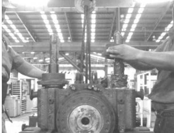
Figura 32. Instalación de resortes y tapaderas
