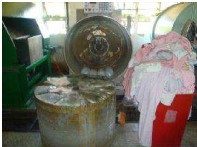
Figura 4. Lavadora y secadora fuera de servicio
