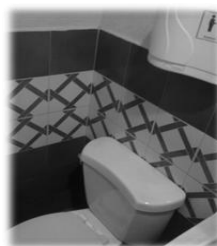
Figura 33. Sanitario del Área de Cafetería
