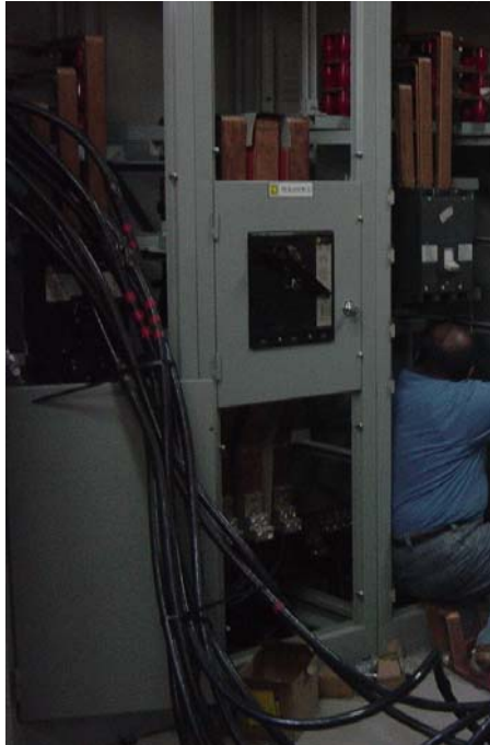
Figura 54. Cables provisionales
