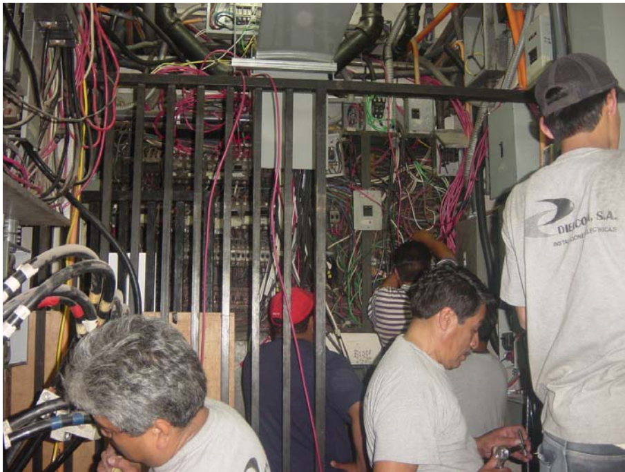
Figura 47. Traslado de los alimentadores
