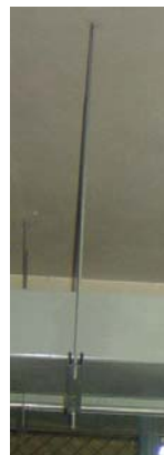
Figura 61. Varilla roscada para sujetar la canal eléctrica
