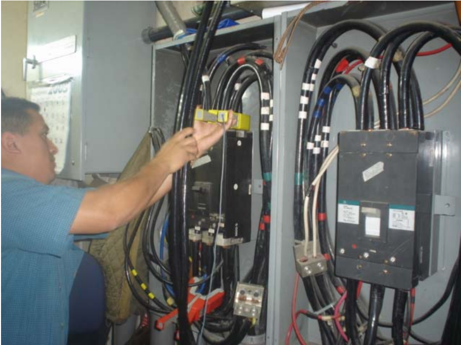
Figura 20. Colocación de ganchos del analizador de carga
