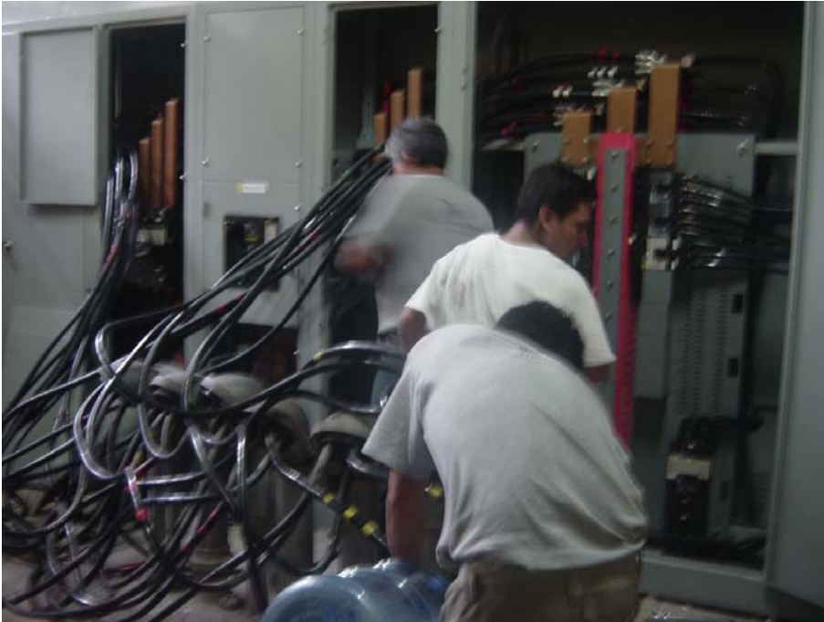
Figura 56. Instalación de circuitos provisionales
