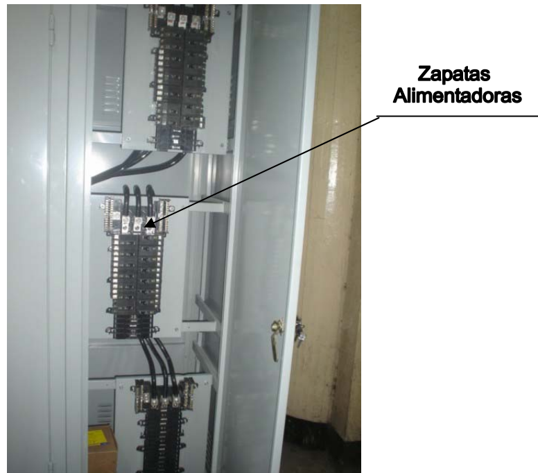
Figura 39. Zapatas de entrada
