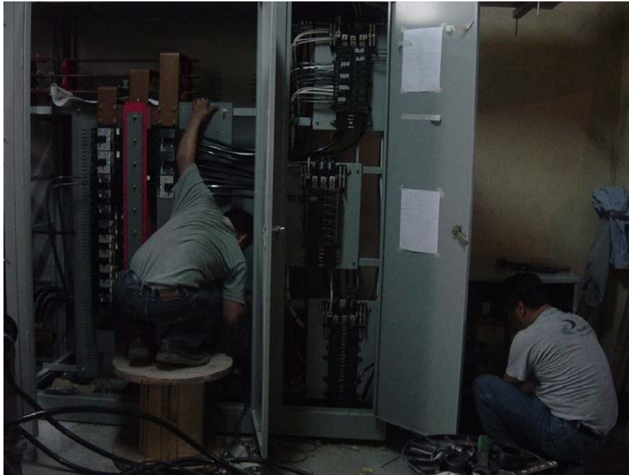
Figura 52. Alimentación de los centros de carga QO desde los interruptores termomagnéticos I-Line
