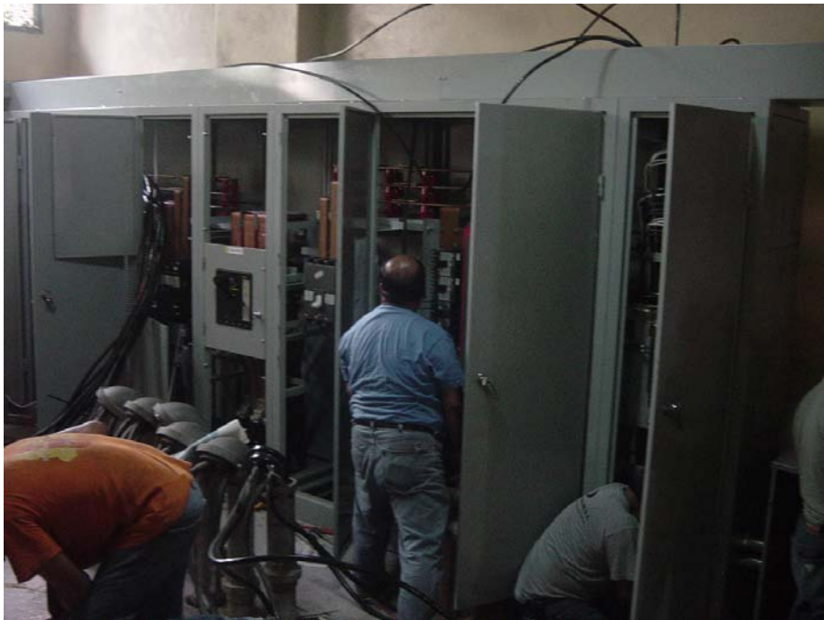
Figura 53. Instalación de canal eléctrica y alimentadores
