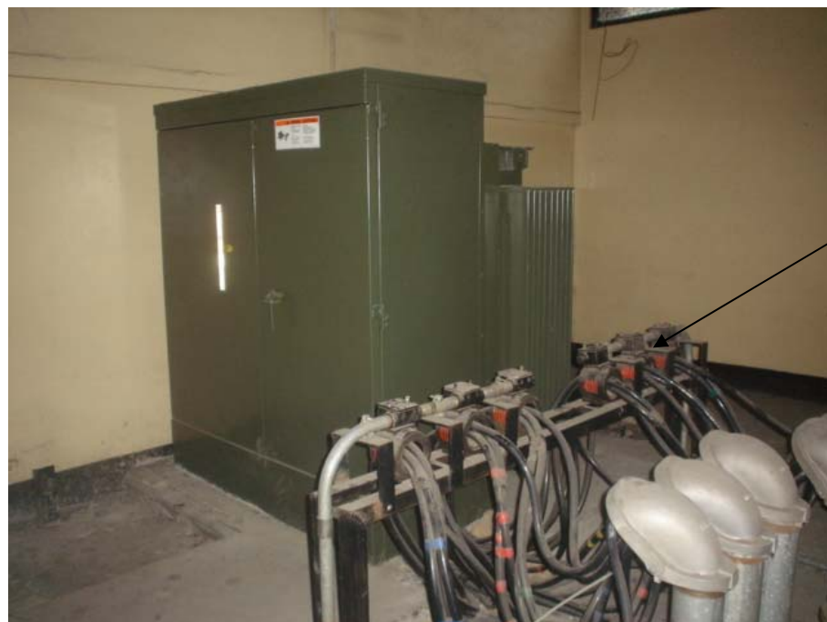
Figura 30. Equipo de medición a desmontar
