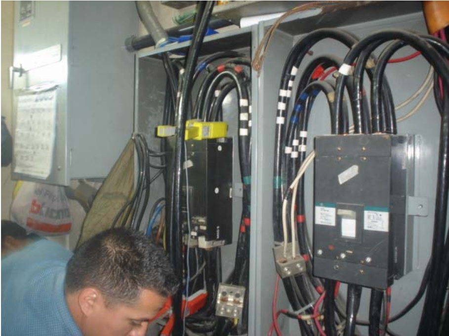
Figura 21. Colocación de analizador de carga
