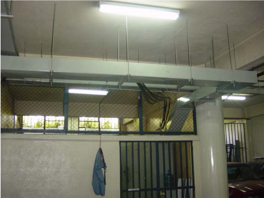
Figura 58. Canal eléctrica
