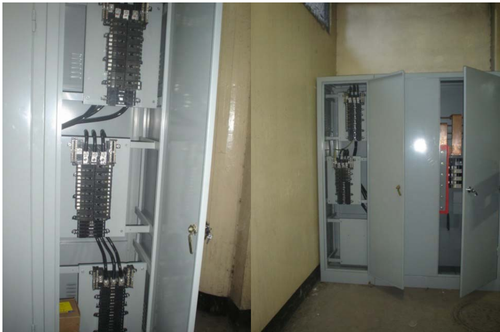
Figura 38. Centros de carga QO
