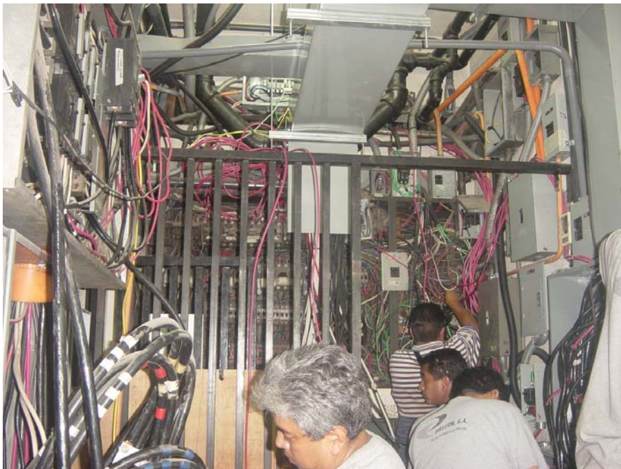
Figura 48. Reubicando de cableado existente
