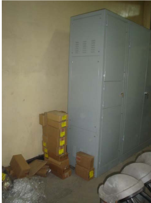
Figura 33. Tableros e interruptores termomagnéticos antes de instalarse
