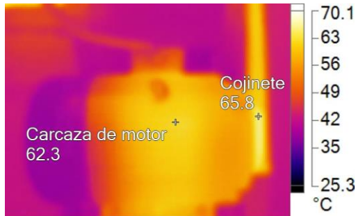
Termografía tesis IR_02197.IS2
