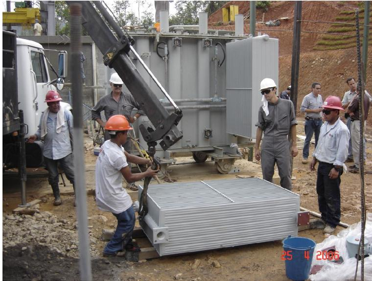
Colocación de tuberías, así como del llenado de aceite dieléctrico en el transformador y en los radiadores, este se llevo a cabo una vez todos los equipos auxiliares habían sido colocados. Los equipos auxiliares fueron ubicados con la ayuda de un camión grúa debido al peso de los mismos.
