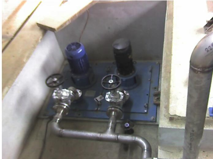
Enumeradas de izquierda a derecha, se observa la bomba de AC y Luego la de respaldo de DC. Montadas sobre una base metálica dispuesta de un orificio en la parte inferior para permitir la toma de agua de las bombas del desfogue de la turbina en la parte baja, la cual luego de pasar por filtros diferenciales es alimentada al grupo de radiadores del generador. La tubería se dispone de manera que al fallar la de AC que es la principal entre a trabajar la de DC.
