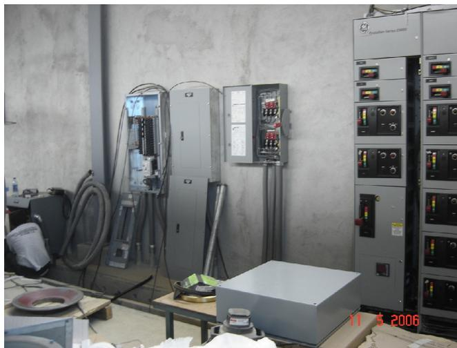
En la imagen anterior podemos observar de izquierda a derecha, el transformador de iluminación, seguidamente el panel de AC, luego el panel de DC, a su lado la transferencia manual, y por ultimo el centro de control de motores. En la parte bajo las tuberías se observa la trinchera que hemos mencionado.
