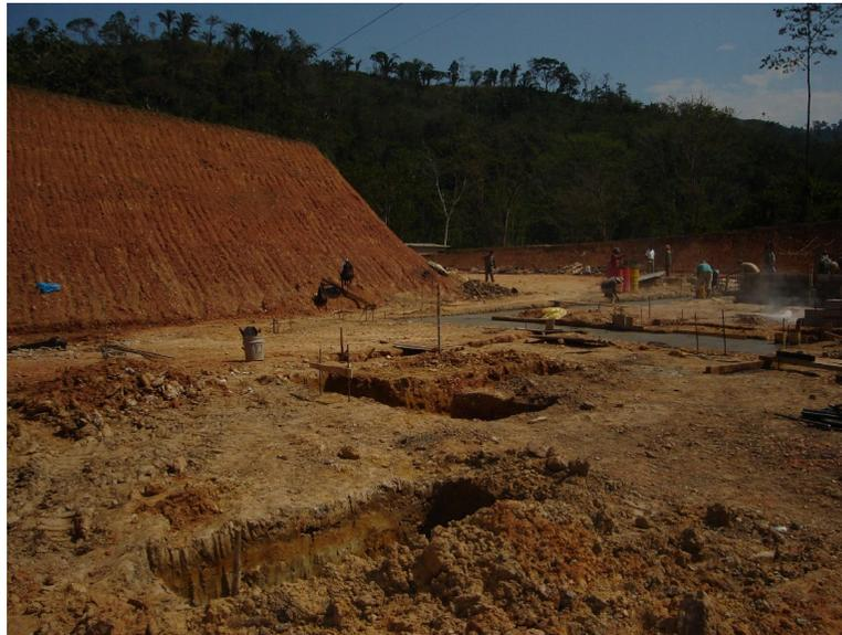
La disposición de la red de tierras, es tal que comprende y abarca la subestación y casa de máquinas como indica el plano, esto antes de las edificaciones estructurales que el proyecto requiere.
