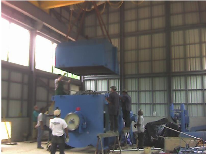
Terminado el montaje del generador se procedió a la colocación de los equipos auxiliares que este requiere para su funcionamiento. El generador necesita para su funcionamiento adecuado los siguientes equipos auxiliares:
