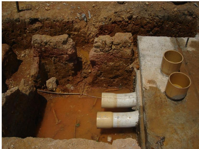
Se observa en este caso, el procedimiento de fundir la tubería a la base de concreto que servirá para el transformador ubicado en la subestación elevadora, cuyas medidas se ubican de forma topográfica según el plano, y en el extremo inferior de los tubos se colocara una caja de registro para luego introducir los cables a esta tubería.
