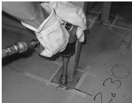
Figura 29. Instalación del banco soporte
