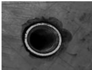
Figura 26. Tarugo instalado en su agujero
