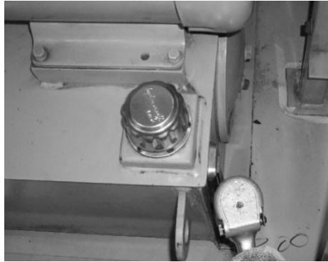
Figura 28. Instalación de sistema de potencia hidráulica
