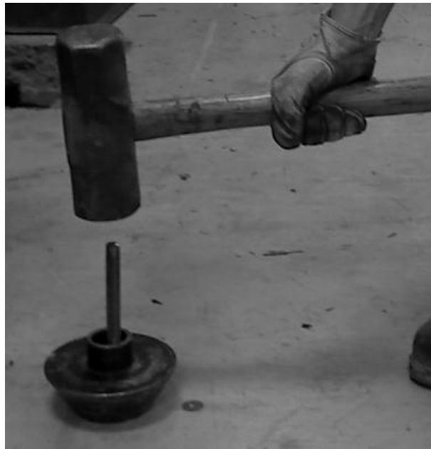
Figura 27. Expansión de tarugo con martillo de 5 libras
