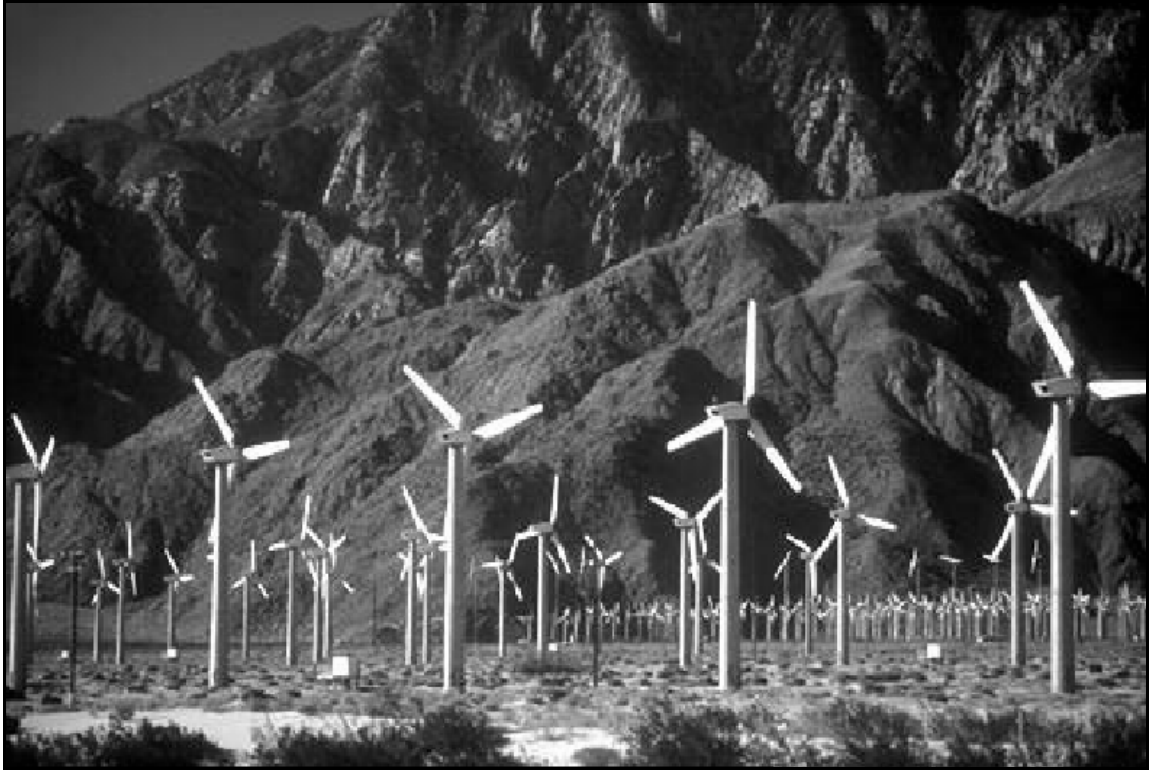
Figura 12. Turbinas eólicas para generar energía eléctrica
