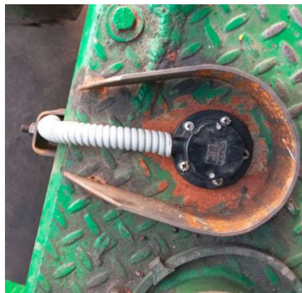
Figura 54. Instalación del sensor de combustible en el tanque
