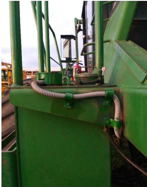
Figura 82. Sensor de combustible instalado en el tanque
