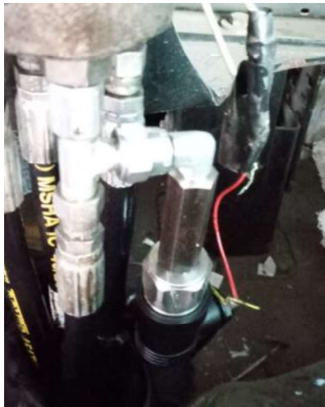
Figura 55. Instalación del sensor (presostato) en la palanca de mandos
