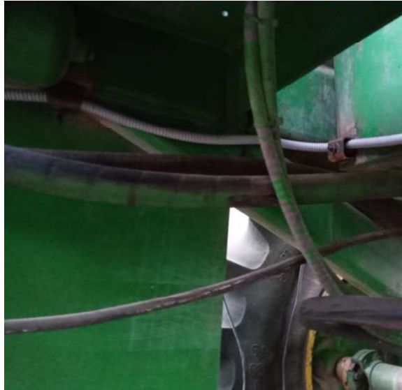
Figura 47. Cableado del sensor de combustible hacia la cabina
