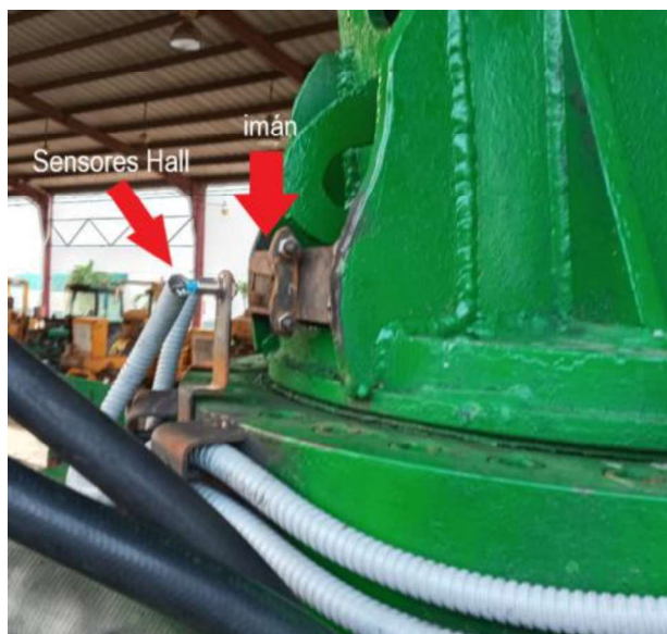
Figura 50. Instalación de imán y sensores de efecto Hall
