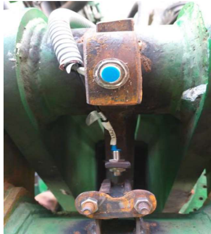
Figura 53. Instalación de sensores de efecto Hall en la pluma
