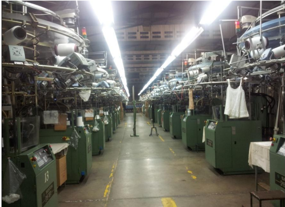
Figura 38. Iluminación área de máquinas circulares
