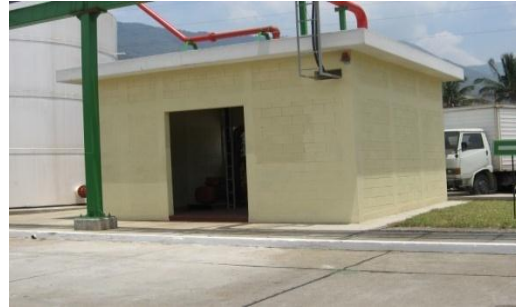
Figura 20. Cuarto de bomba y tanque de almacenamiento
