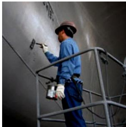
Figura 54. Acabado por revestimiento topcoat para buques mercantes
