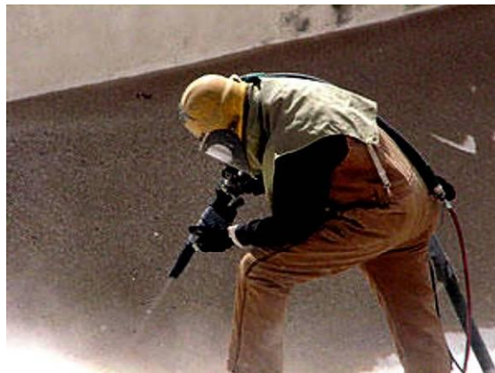
Figura 46. Chorro de abrasivo a presión
