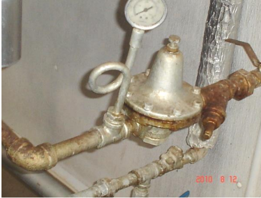
Figura 24. Accesorio núm. 1 al 8 de tabla de accesorios con falla
