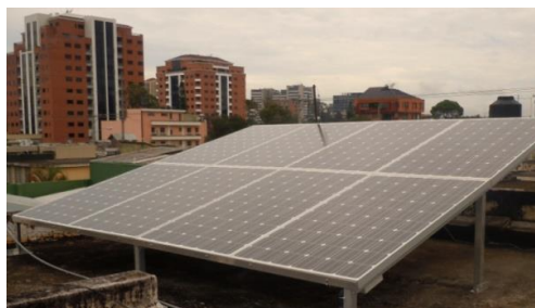
Figura 29. Fotografía de instalación de paneles solares
