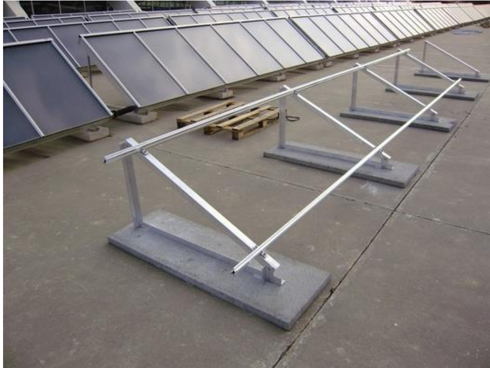
Figura 34. Fotografía de instalación de paneles solares
